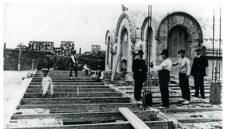
El Mercat, poc abans d'inaugurar-se el 1915 i durant la construcció.
